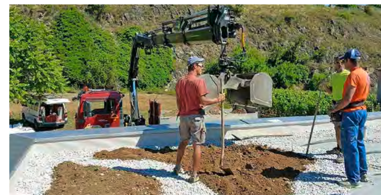
Pilotprojekt Acclimatisation: Erstes Biosolardach auf einer privaten Villa in Sion.
