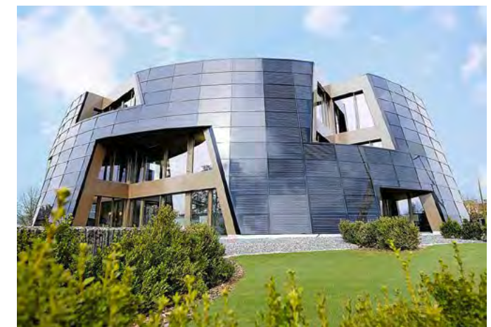
Die skulpturale Form des Gebäudes wird durch die PV-Fassade akzentuiert: Firmensitz BF Architekten Sursee (LU), Realisation 2011/2012, BF Architekten Sursee AG.
