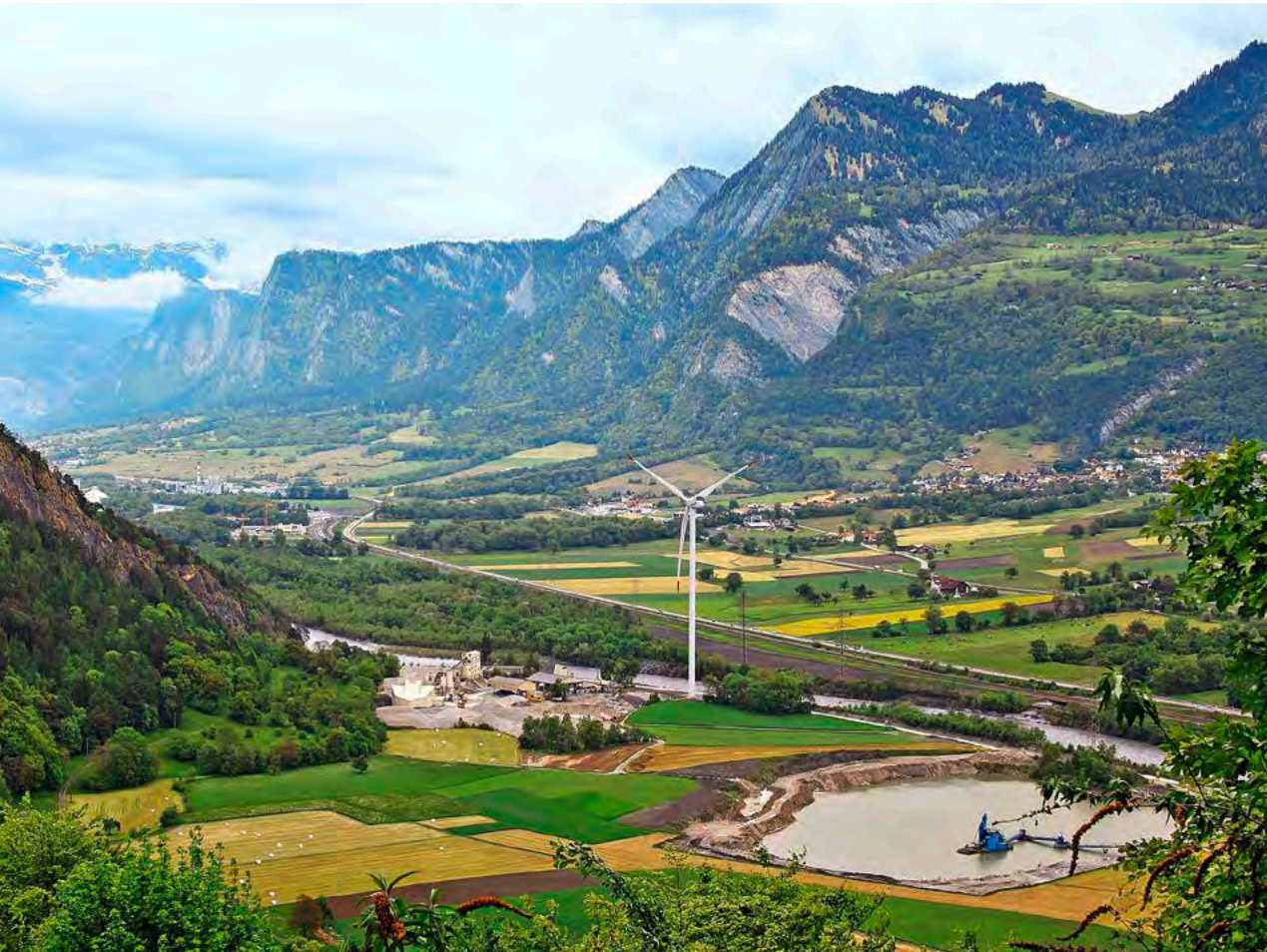
Geschickte Standortwahl: Inmitten der Talebene nahe einer Industriezone stört der Bau die Anwohner optisch wie akustisch nicht.
