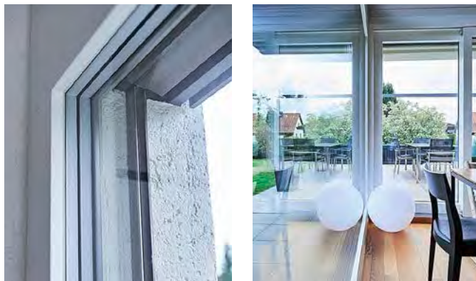
Die neuen, dreifach verglasten Fenster sorgen für ein neues Wohngefühl und drosseln die Heizkosten von Familie Allemand.
