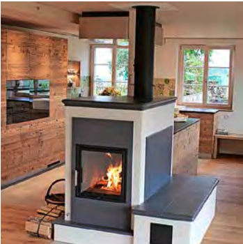
1 Speicherofen von Nyffenegger → www.nyffenegger-Ofenbau.ch
