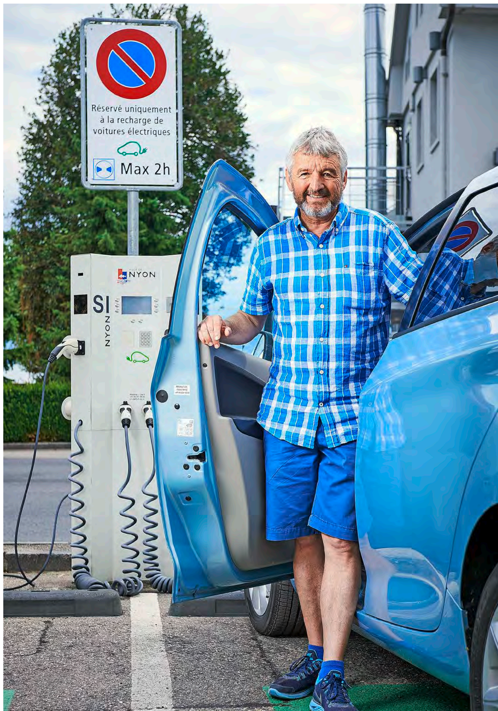
Stadtpräsident Daniel Rossellat vor einer der Ladestationen für Elektroautos auf den gemeindeeigenen Parkplätzen von Nyon.
