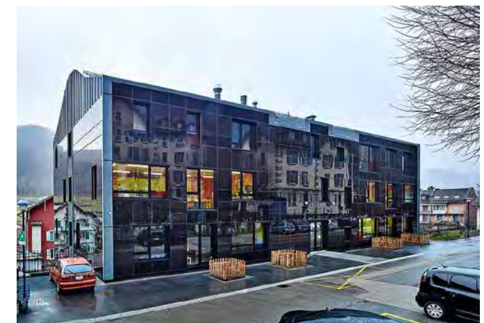
Erweist mit spiegellnden PV-Modulen der Umgebung die Referenz: Erweiterungsbau Collège de Vallorbe (VD), Realisation 2011/2012, Batineg/Atlante SA.
