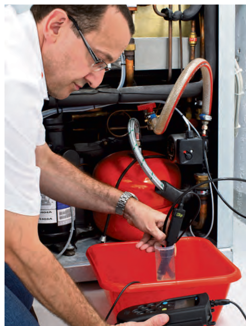
Sorgfältige Zustandsanalyse vor Ort
