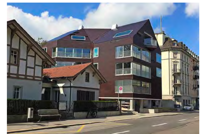
Je nach Licht wirkt der mit PV-Glasmodulen umhüllte Bau in Zürich dunkelrot, violett oder silbrig. MFH, Zürich, Realisation 2016/2017, Huggenbergerfries.
